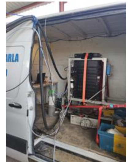
Equipos de análisis de gases de escape
