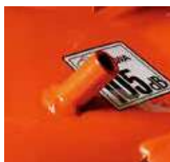
Toma de manguera para limpieza de la plataforma
